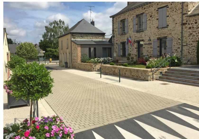
Revêtement différencié au mortier hydraulique
