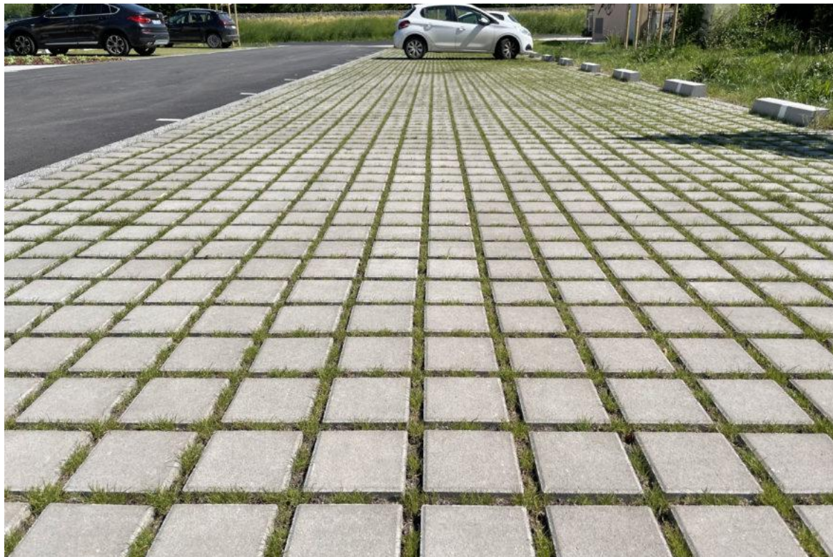
Stationnements avec revêtement perméable
