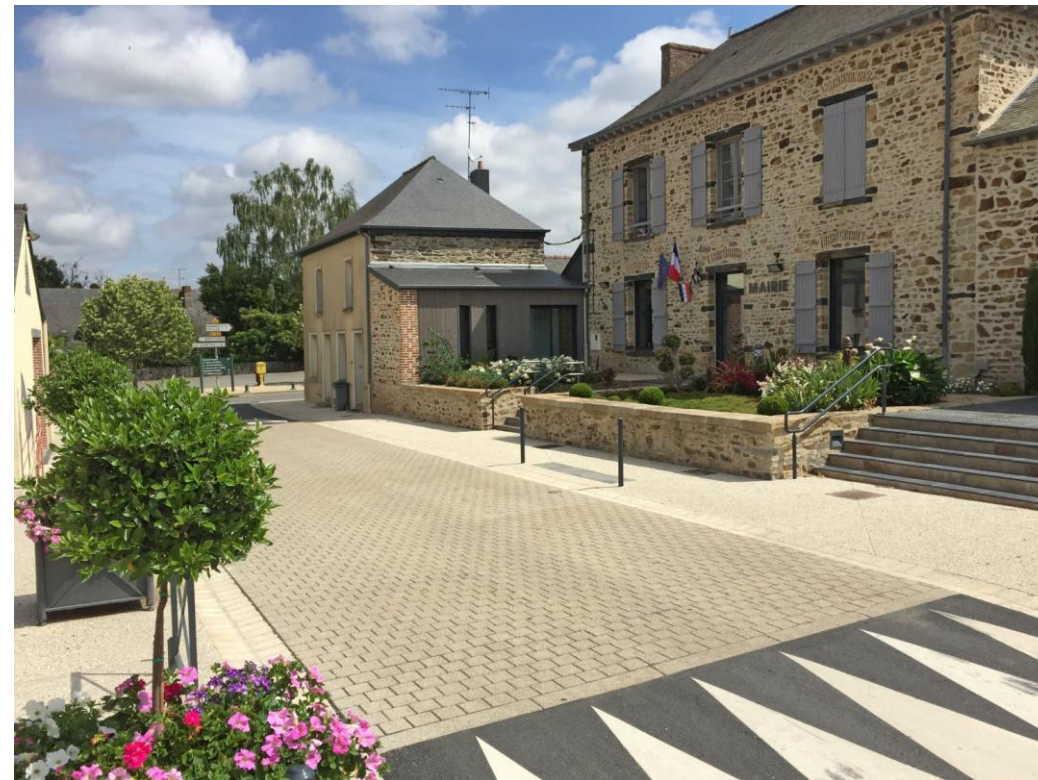
Revêtement différencié au mortier hydraulique
